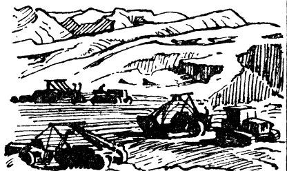
Работы в горном районе Уцзю
