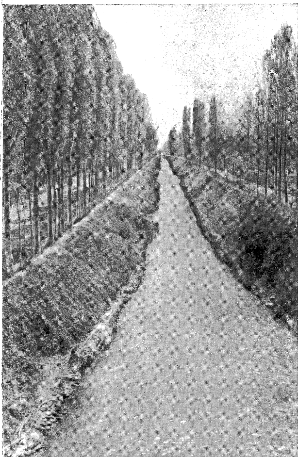
Берега оросительных каналов обсаживают деревьями, чтобы они корнями укрепляли их земляные стенки.
